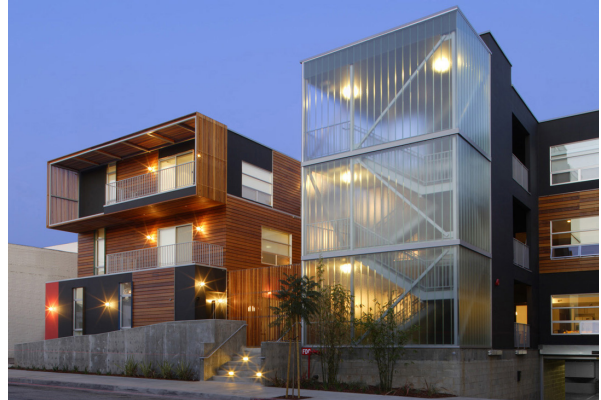
▲ Plex résidentiel sur coursière (Courtyard housing development), West Hollywood, CA © LOHA Architects
