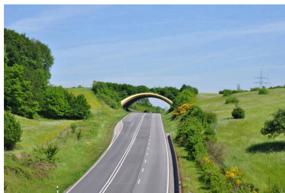
▲ Écoduc (passerelle faunique) pour la grande faune au-dessus d'une route © Radioeveil
