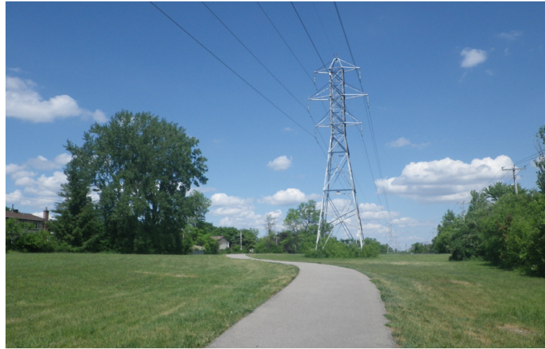
▲ Piste cyclable sur l'emprise d'Hydro-Québec à Kirkland
