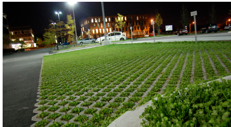
▲ Matériaux de revêtement perméables © Cécile gladel
