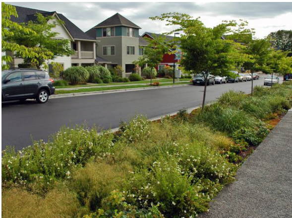
▲ High Point Neighborhood, Seattle. Rues avec rétention d'eau dans les noues végétalisées et trottoirs en béton poreux © flickr
