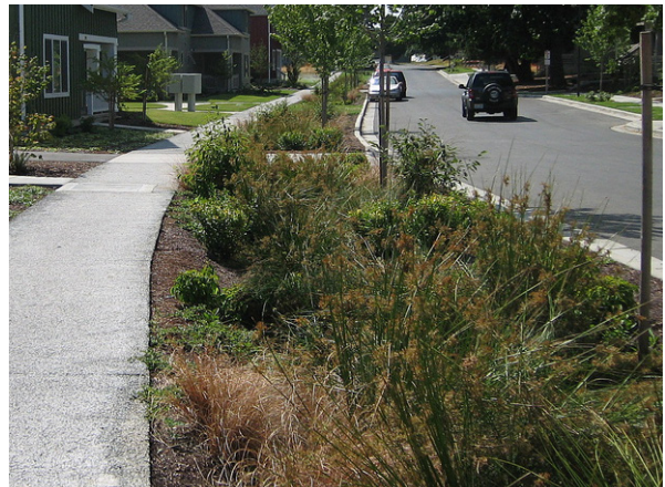
▲ High Point Neighborhood, Seattle. Rues avec rétention d'eau dans les noues végétalisées et trottoirs en béton poreux © flickr
