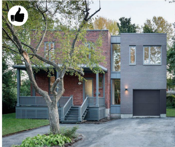
^ La partie agrandie, dans sa volumétrie, préserve l'importance de la forme bâtie existante.
