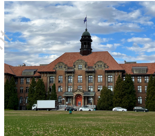
Figure 27 — Bâtiments compris sur le campus Macdonald
