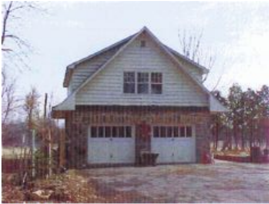
38. Garage du bâtiment A, 2003 (Ville de Ste-Anne-de-Bellevue) 39. Bâtiment C, 2003 (Ville de Ste-Anne-de-Bellevue)
