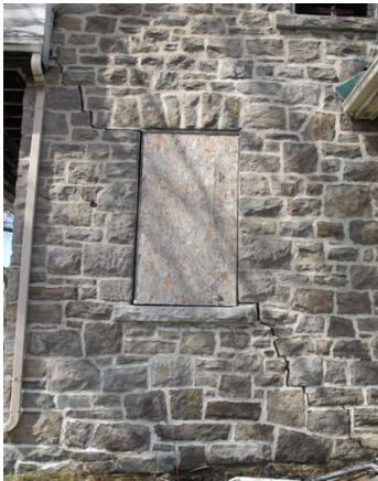
88. Fissuration dans le mur pignon est (Lafontaine & Soucy 2014)
