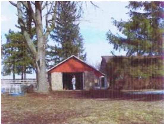
40. Garage du bâtiment C, 2003 (Ville de Ste-Anne-de-Bellevue) 41. Bâtiment D, 2003 (Ville de Ste-Anne-de-Bellevue)
