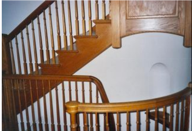
71. Vue de l'escalier principale prise du premier étage, 2006 (Guillaume St-Jean, Flickr)
