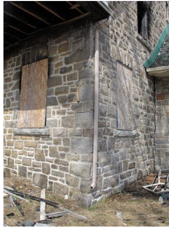
81. Chainage d'angle sud-est du volume principal (Lafontaine & Soucy 2014)
