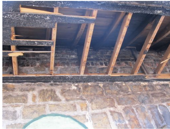
88. Fissuration dans le mur pignon est (Lafontaine & Soucy 2014)
