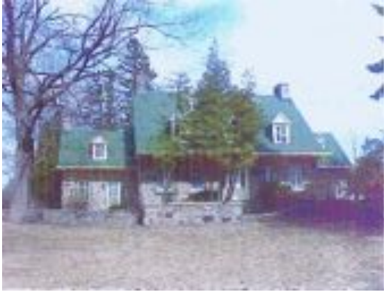
36. Bâtiment A, 2003 (Ville de Ste-Anne-de-Bellevue) 37. Bâtiment A, 2003 (Ville de Ste-Anne-de-Bellevue)
