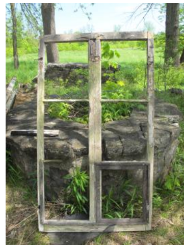
Châssis extérieur, côté intérieur
