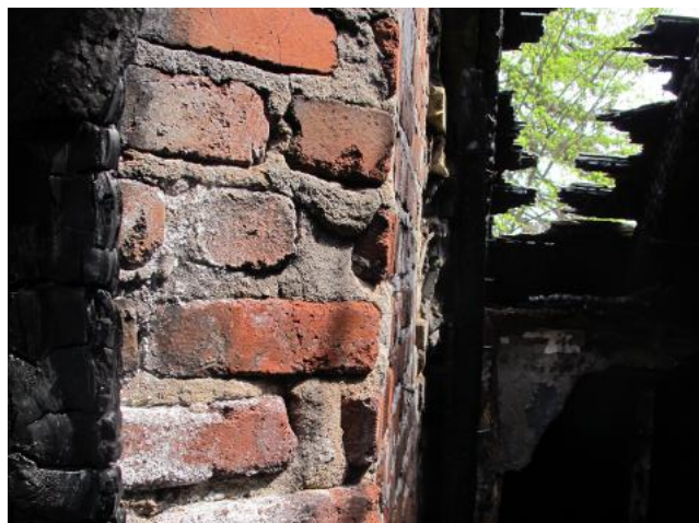
Mur pignon en brique du côté intérieur, 22 mai 2019
