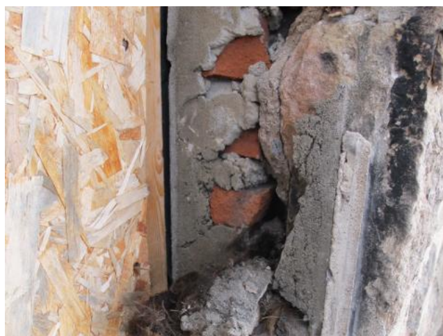
Briques dans la composition du mur, ouverture no. 7, 2014 (aujourd'hui placardée devant ce détail)
