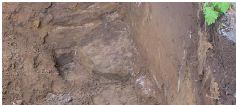
P.E. no. 3, fondation coulée sur une pierre existante
