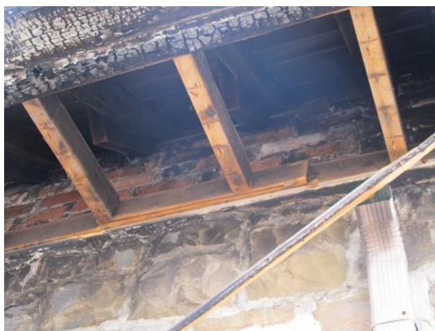
Mur nain en brique, derrière le débord de toiture, 2014
