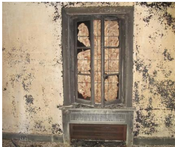
Fenêtre type façade avant, côté intérieur, 2014
