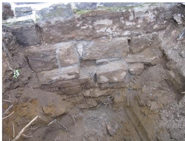
P.E. no. 4, suite au curetage de surface et au rejointoiment
