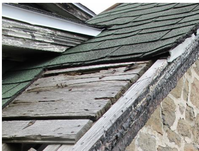
Platelage et revêtement de bardeaux d'asphalte, 2019
