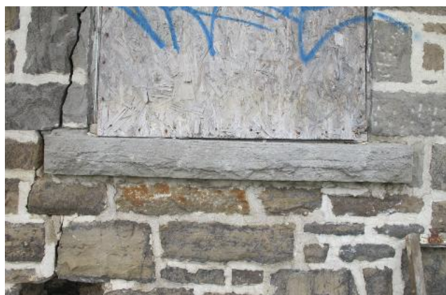
Allège no. 13, en bon état
