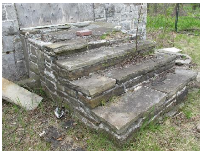
Escalier de l'entrée est, 2019
