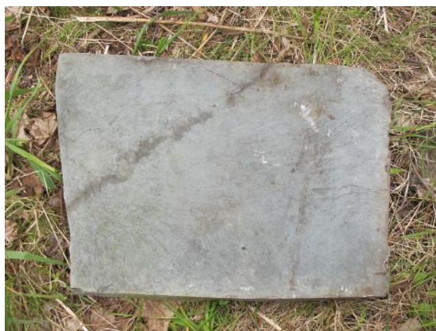
Ardoise du palier de l'escalier est
