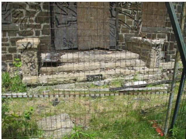
Escalier de l'entrée principale, 2019
