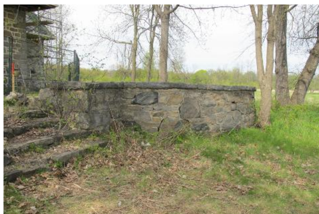
Escalier central et section en demi-cercle du muret
