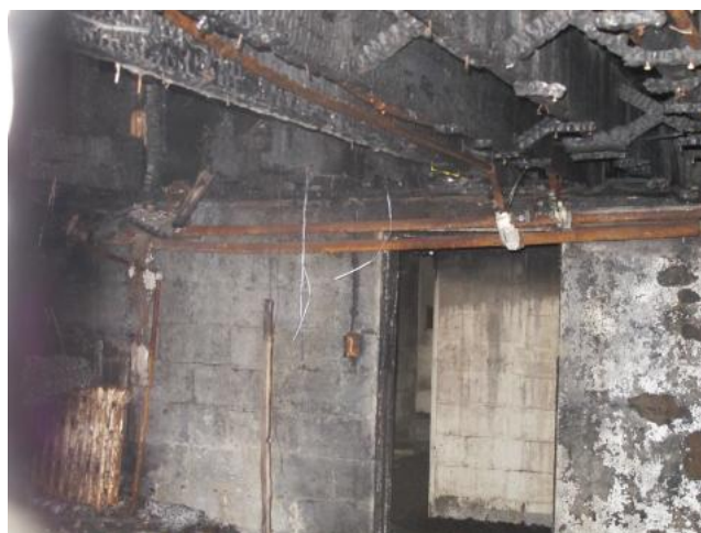
Murs en béton au sous-sol, 2014
