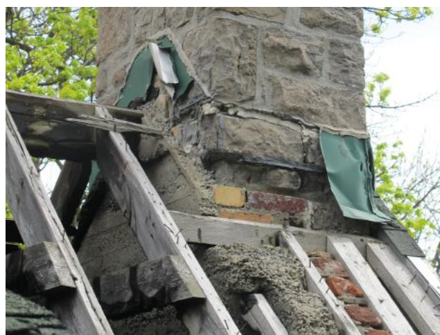
Cheminée en béton, briques et pierres, 2019
