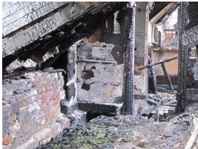
Briques visibles du côté intérieur des murs, 22 mai 2019
