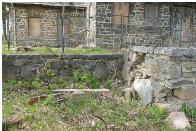
Deux hauteurs de muret
